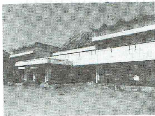
解体予定の関ヶ原町老人福祉センター
